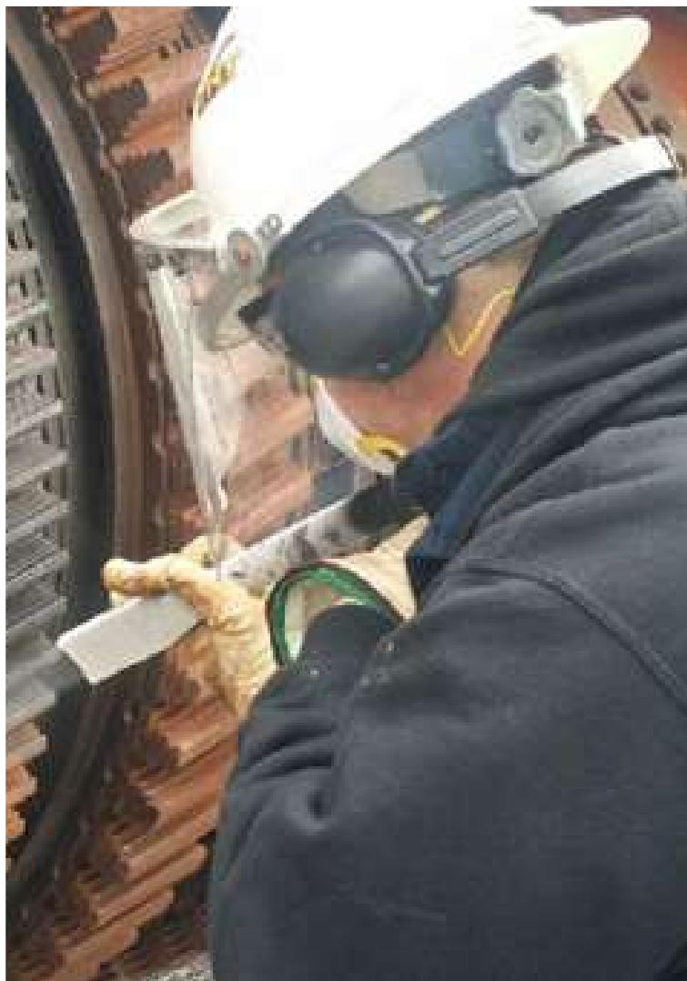
Čistiaci účinok suchých ľadových peliet spočíva v oslabení väzby medzi kontaminantom a povrhom vyvolaním tepelného šoku. Výhoda tryskania suchým ľadom je eliminácia tvorby sekundárneho odpadu a rozpúšťadiel bez nutnosti odstávky a prerušovania kontinuity výrobného procesu.
